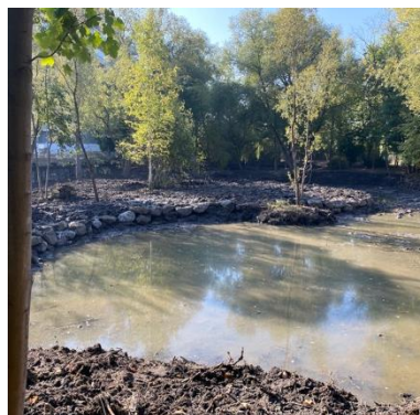
Oever met steenbestorting
