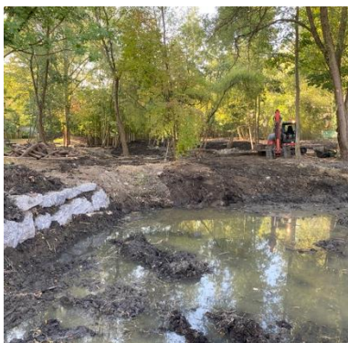
Oever met steenbestorting
