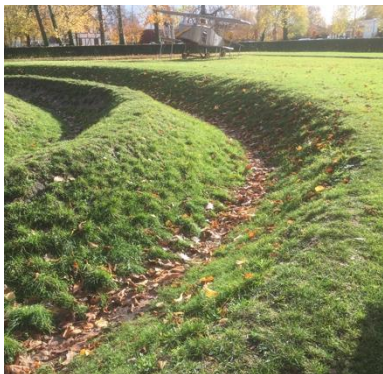
Afwaterings- en infiltratiesloot
