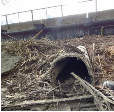
Overloopleiding onder de modder vóór de werken
